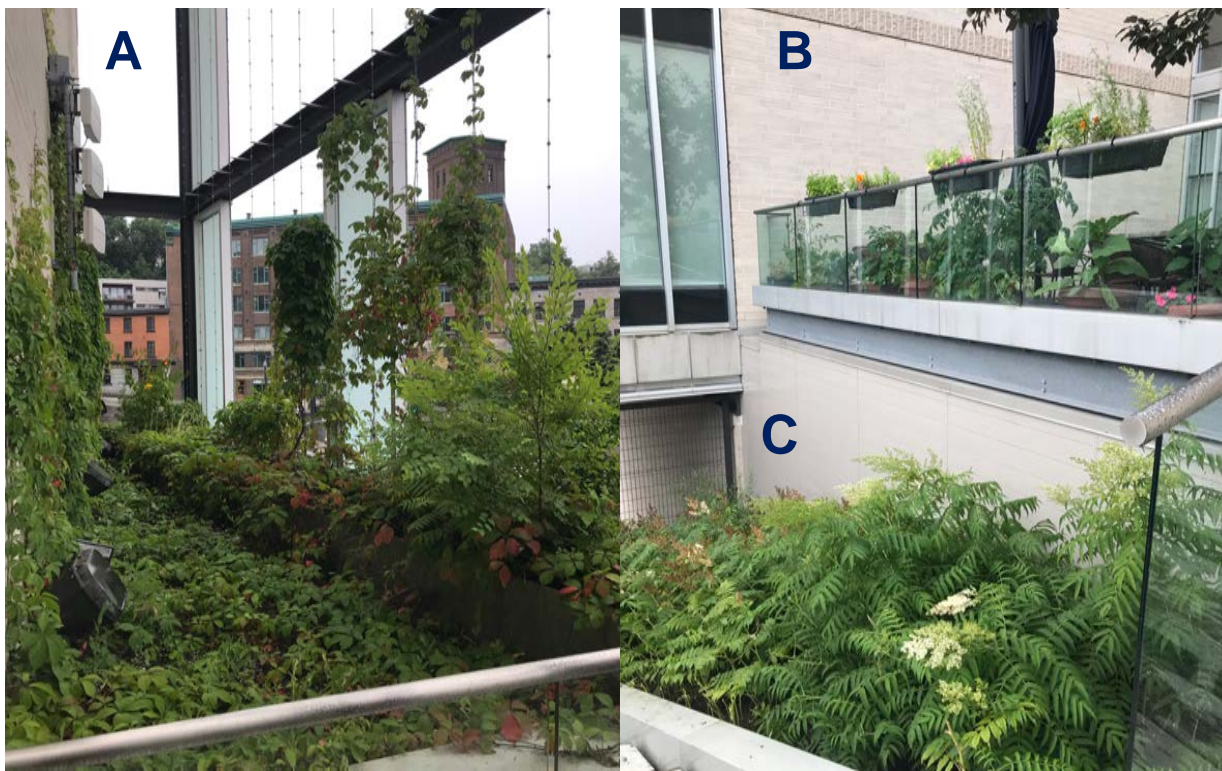
Figure 2. A. Toit/mur végétal peuplé de plantes adventives. B. Jardin mellifère et maraîcher. C. Escalier extérieur avec plantes ornementales entretenues.
